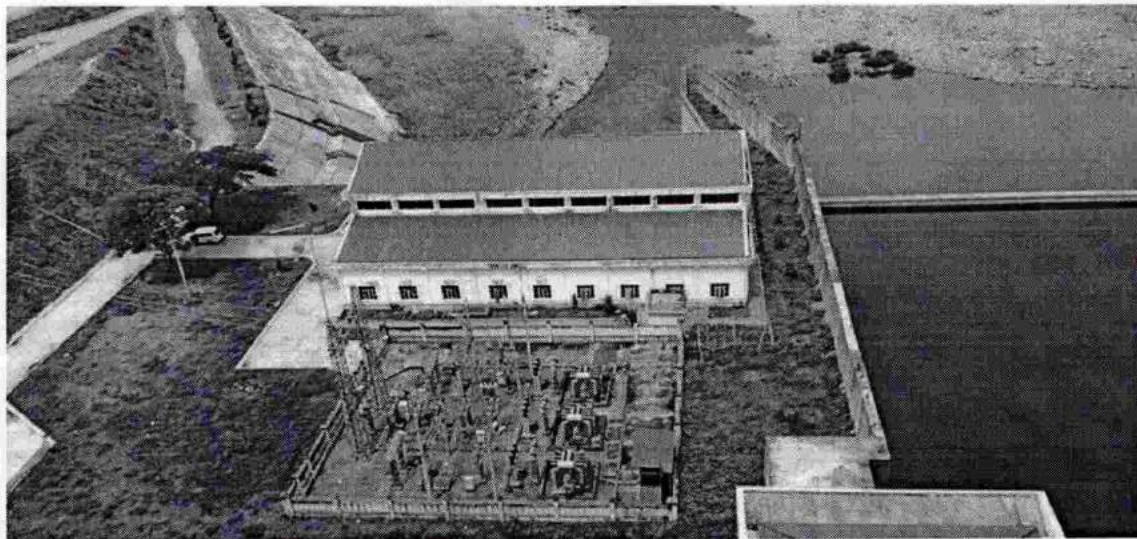
Hình ảnh về Nhà máy Thủy điện Nước Trong
