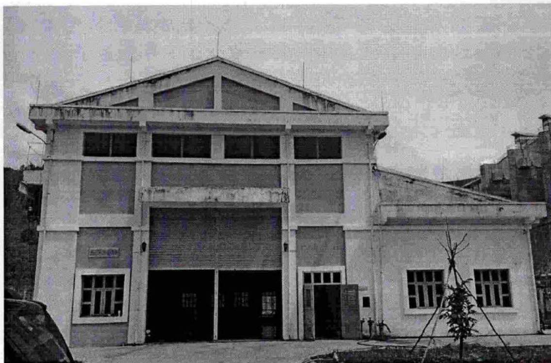
Hình ảnh về Nhà máy Thủy điện Nước Trong
